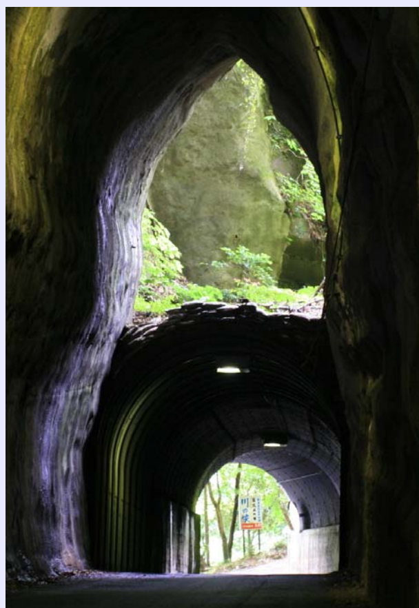
向山(上)・共栄(下)トンネル
